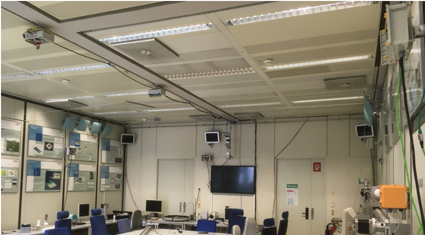
Abbildung 2.11: Messaufbau in der Laborumgebung. Die Basisstationen sind an den Wänden montiert.
