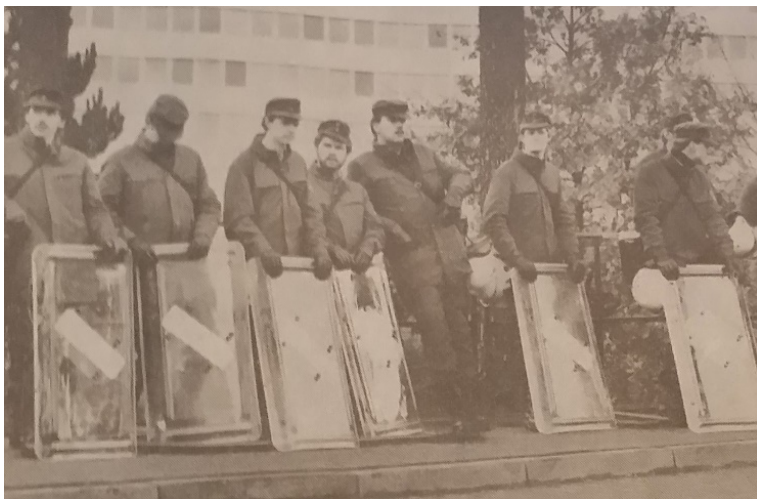
Abbildung 25: Polizeikordon vor dem KWU-Hauptgebäude in der Paul-Gossen-Straße 1, 15.12.1986.
